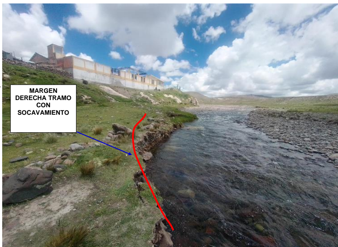
FIGURA N° 03: EN LA TEMPORADA DE MAXIMAS AVENIDAS, LA QUEBRADA JACHAÑAMAYO SOCAVAMIENTO EN LA MARGEN DERECHA DE CENTRO POBLACION JACHAÑAMAYO.
