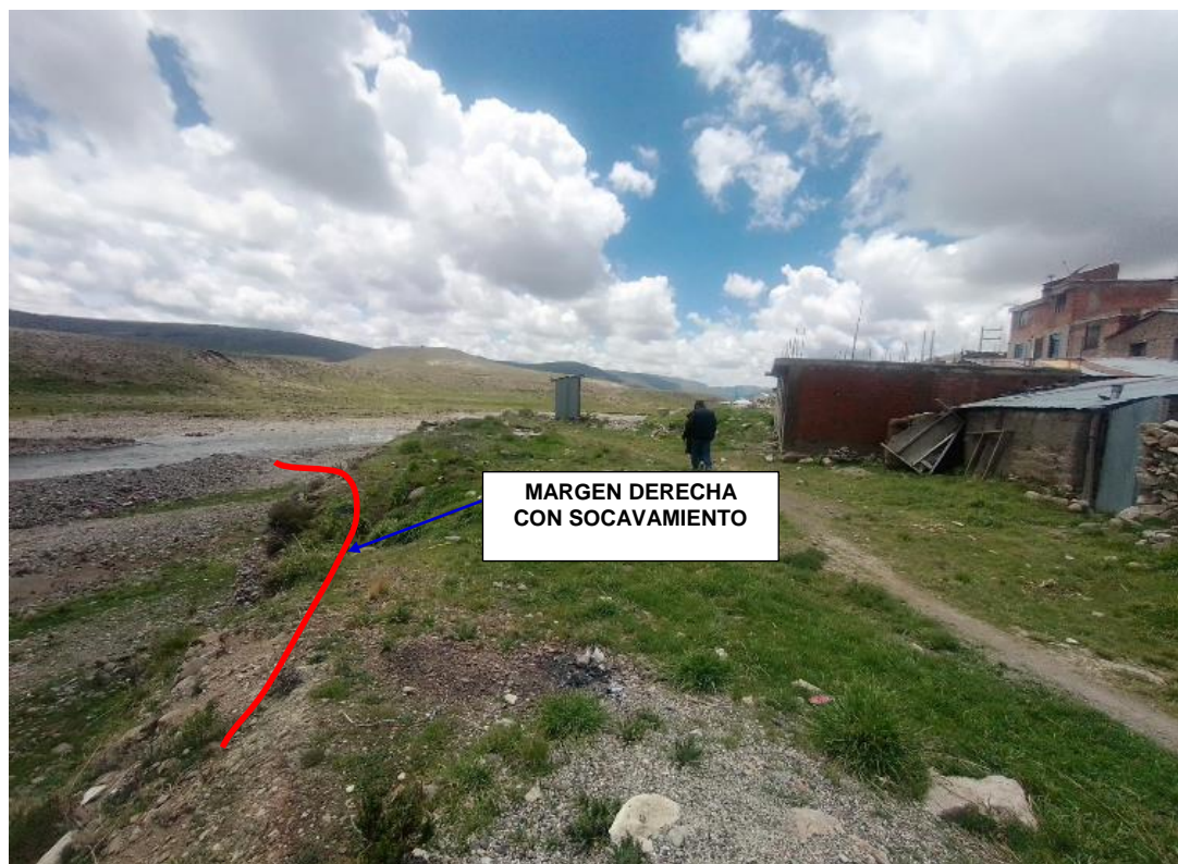
FIGURA N° 02: QUEBRADA JACHAÑAMAYO EXPUESTO ANTE SOCAVAMIENTO EN EL CENTRO POBLADO.
